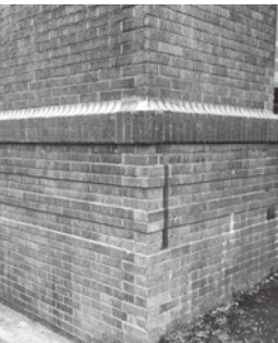
窓下のタイルを工夫し基礎と壁を表現している
