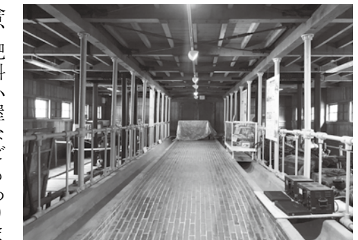
煉瓦の床、鑄鉄の柱のある牧牛舎の南側通路
