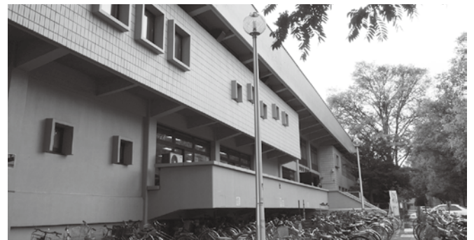
構造を工夫して軒やベランダを張り出し、水平線を強調している
