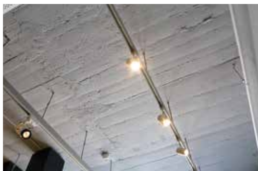
天井のコンクリート型枠の跡
