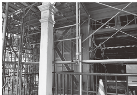
写真1 (奥) 建物の構造を改変しないようにはめ込まれた耐震補強材
