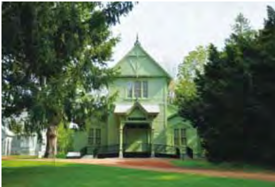
写真1 博物館本館の外観
